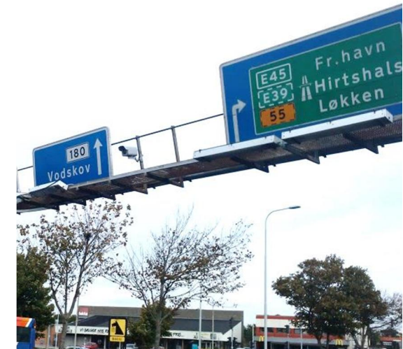
Figur 1.7: Videokamera (placeret i portal) som alternativ detekteringsform i stedet for induktionsspoler.
