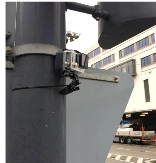
Figur 2.6: Opsætning af videokamera i signalmast.
