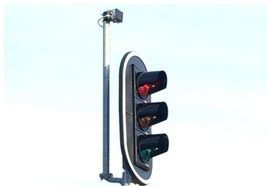
Figur 1.8: Radar (placeret i eksisterende signalmast) til detektering af trafikanter i et signalreguleret kryds.
