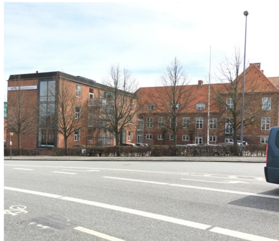
Figur 3.2: Uddannelsesinstitutionen, UCN, som er beliggende midt på strækningen.
