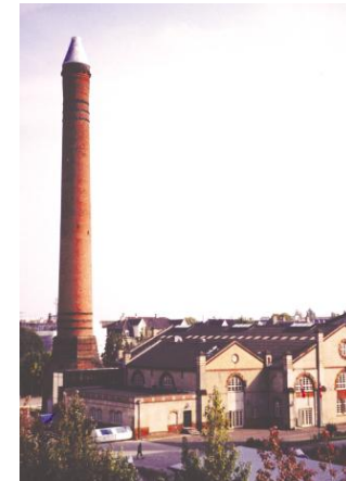
Første anlæg på Frb. Indtil 1934 og derefter dampvarmecentral indtil 2000. I dag "kedel hallen". (Foto: Rambøll).
