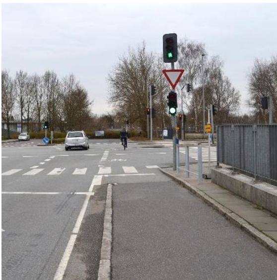
Figur 4.27: Krydset Rismarksvej/Middelfartvej (J), efter cyklistgelænderet er sat op.
