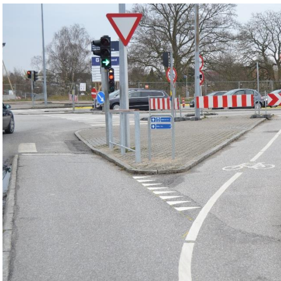
Figur 4.29: Krydset Bogensevej/Rismarksvej (K), efter cyklistgelænderet er sat op.
