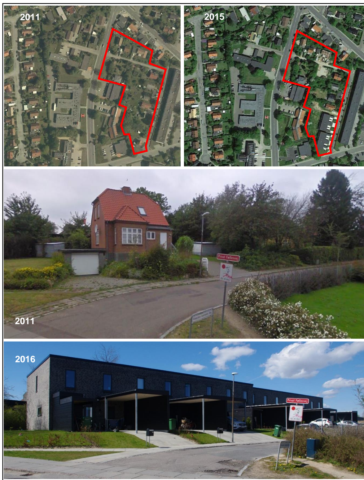
Figur 27: Et fortætningsprojekt ved Kræsten Iversensvej i Højbjerg, Aarhus. Projektet indebærer nedrivning af parcelhuse, som det fremgår af billedet øverst til venstre og billedet i midten, der erstattes af tæt-lavt byggeri, som det kan ses på billedet nederst og nederst i billedet øverst til højre. De øverste billeder er ortofotos fra Google Earth (2011 & 2015), det midterste taget med Googles Streetview funktion (Google 2016), og det nederste taget af forfatterne den 1. maj 2016.
