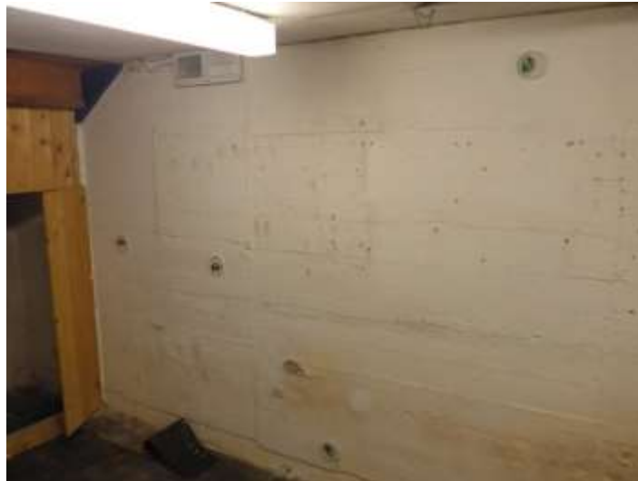
Figur 18. Opsætning af fugthætten forskellige steder på en kældervæg. Her på Knudsbølvej 76 i Rødovre.
