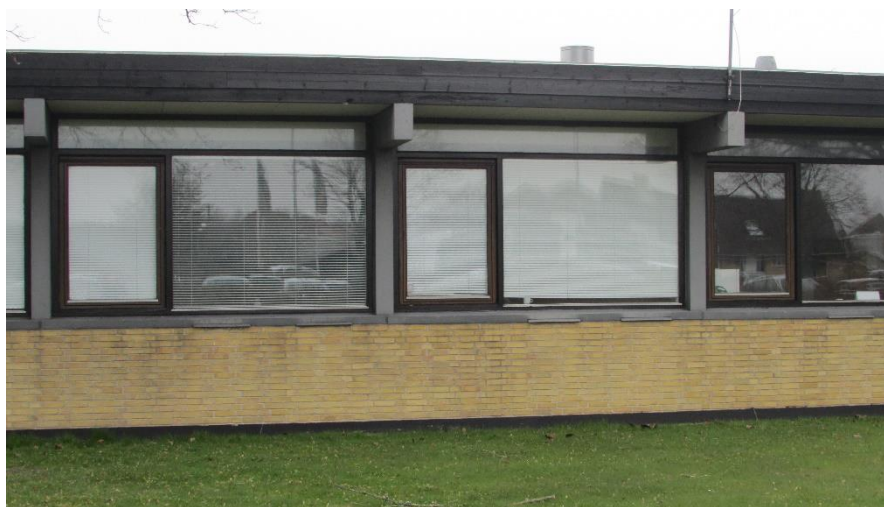
Figur 10. Sydvendt facade med vinduer i eksisterende bygning.
