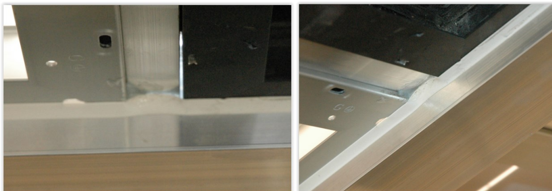
Figur 35, Krydssamling set fra underside celler, utæt og fuget
