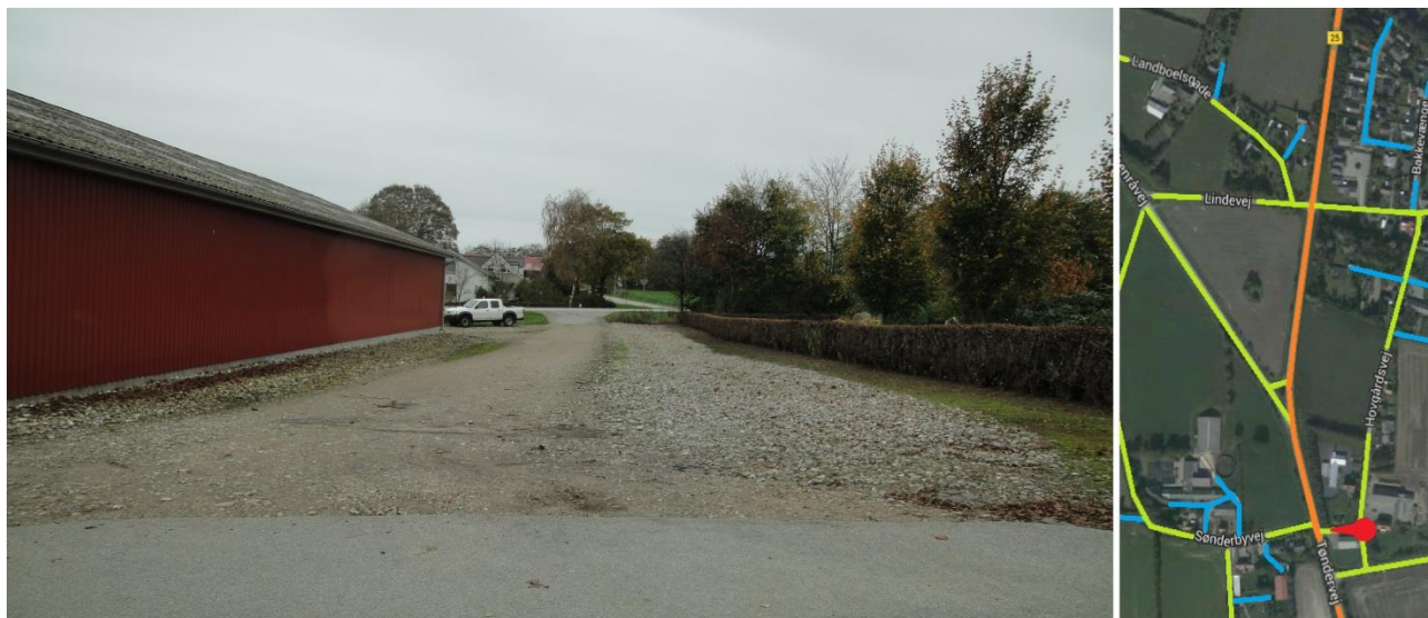
Figur 20: Hal med overkørsler ved den hvide bil ud på Tøndervej og ud på Hovgårdsvej
