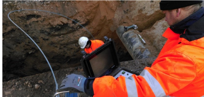
Figur 12: Undersøgelse af rør med TV-kamera
