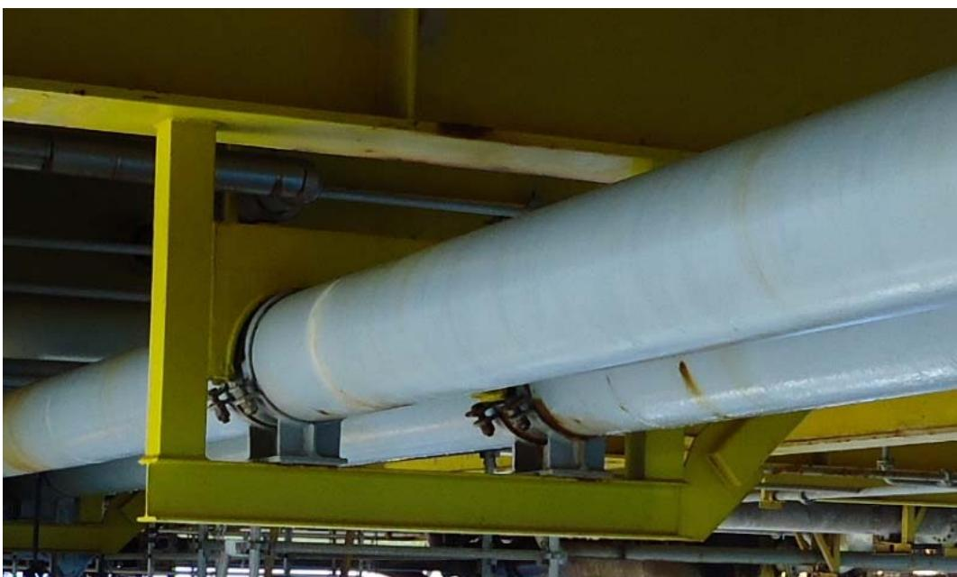
Figur 60 – Billede af en af rammerne fra inspektionen offshore. Viser at rammen er svejst på en stor HE bjælke på undersiden af Cellar-Deck.
