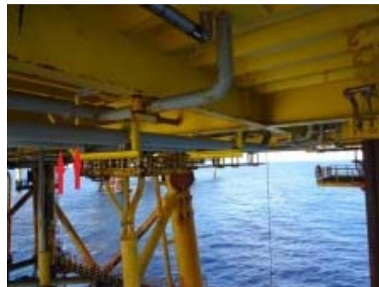
Figur 10 – De to rør, hvor de føres igennem Cellar-Deck og videre op i processen. Rørene er markeret med røde pile.
