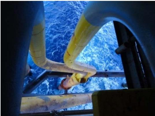
**Figur 7 – Rørene, hvor de forlader caisson'en og derefter fortsætter horisontalt ind under Cellar-Deck.**
