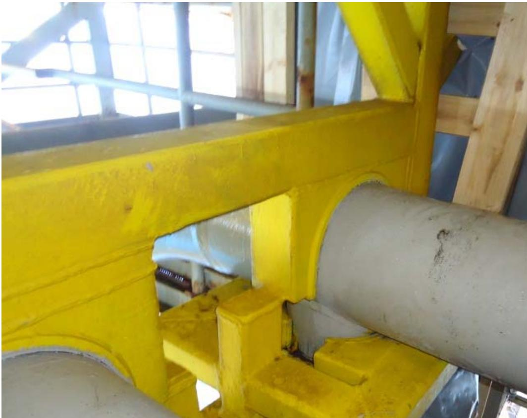
Figur 1 – Billede af rørsupport taget under inspektion offshore. Viser at rørsupporten omkring røret ikke kan demonteres for inspektion.
