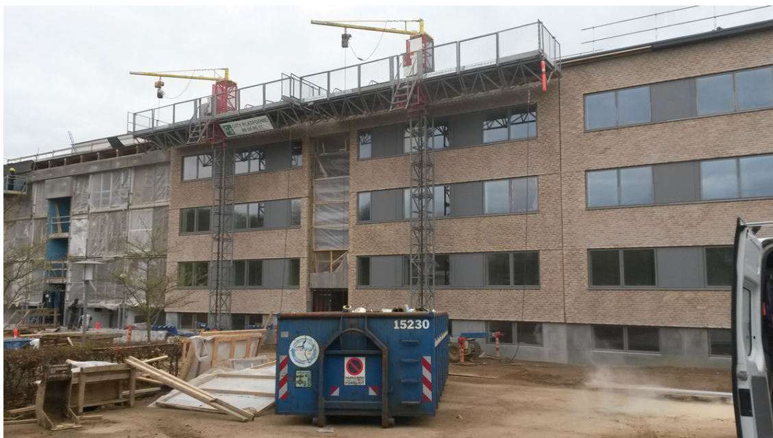
Figur 9.1. De renoverede blokke i Sønderparken som de ser ud under renoveringen.
