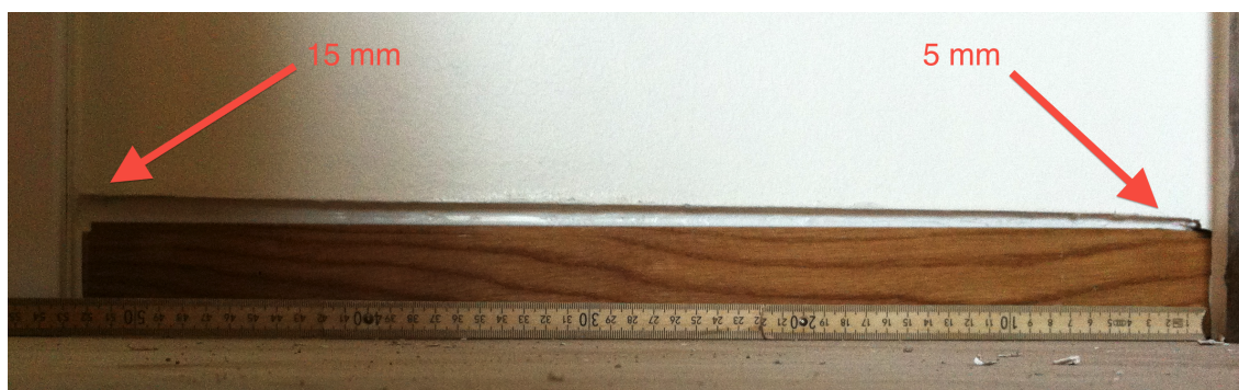
Figur 9.3. Eksempel på svingende fugehøjde over fodlisterne på Musikkens Hus.
