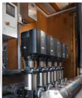
ill. 1.1.11. Placering af Grundfos Hydro MPC
