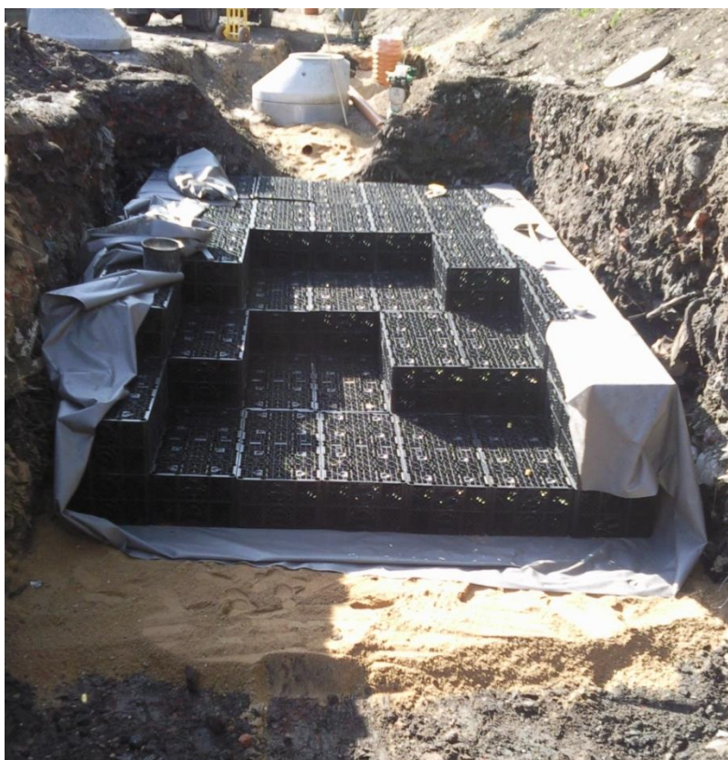
Figur 30: Eksempel på faskineløsning til nedsivning af regnvand.
