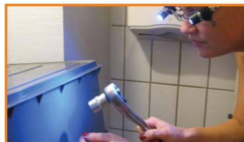
ill. 40: Lyskeglen er rettet direkte mod området hvorpå der arbejdes, og der forekommer kun begrænsede slagskygger.
