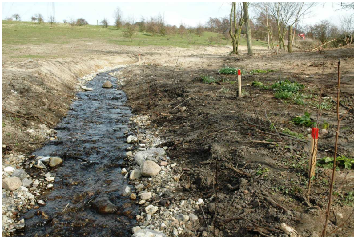
Figur 43: Strækning 2 efter restaurering.
