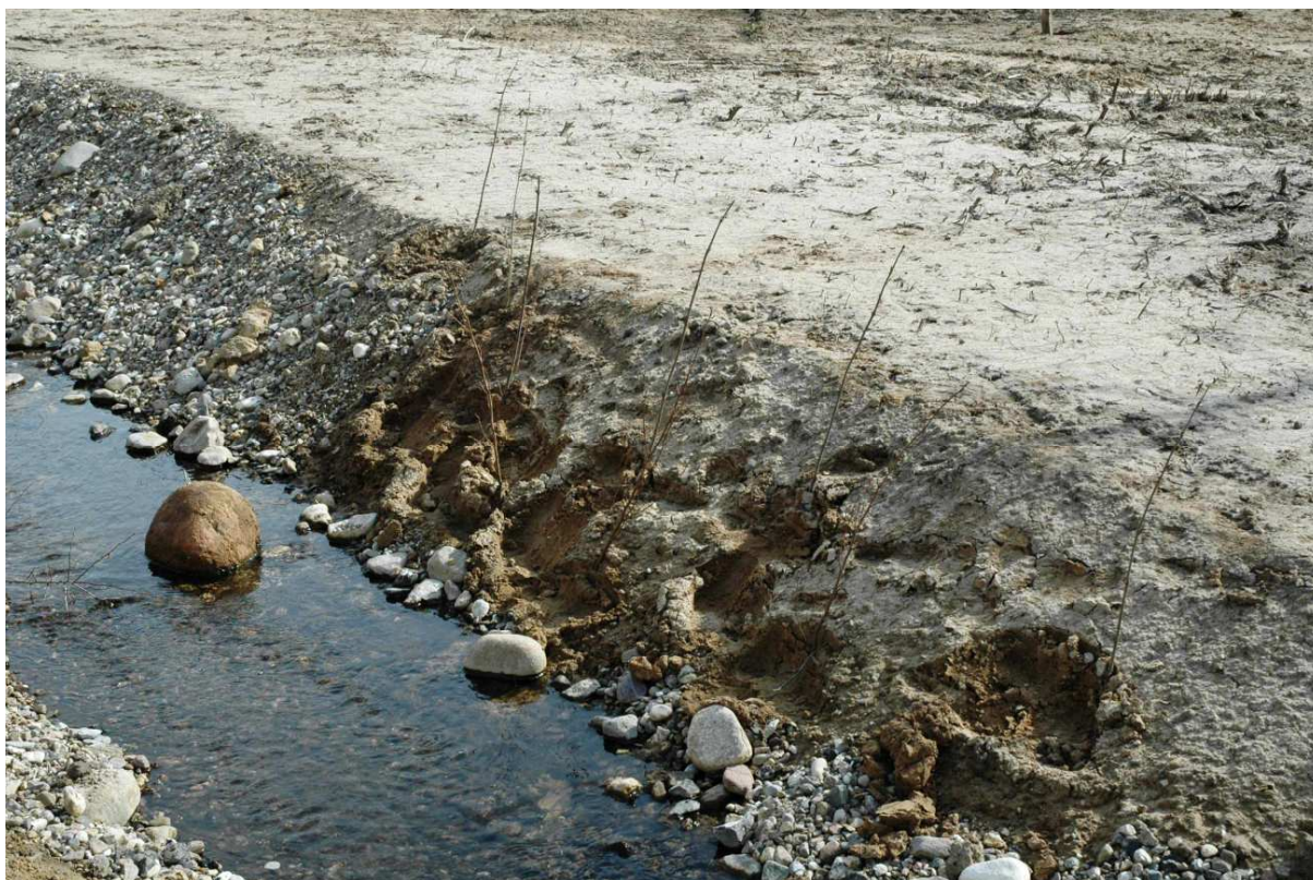
Figur 60: Bepantning af Skamlebækkens sider
