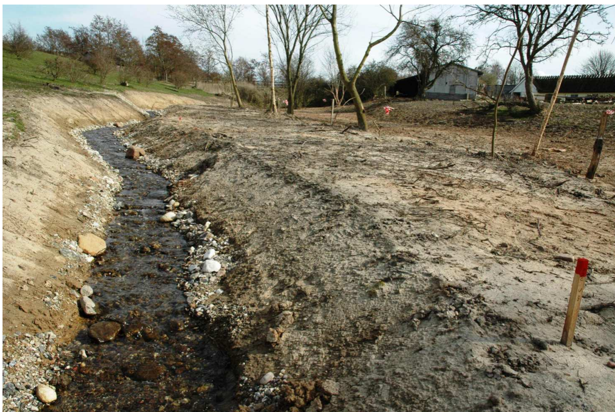
Figur 48: Strækning 3 efter restaureringen.
