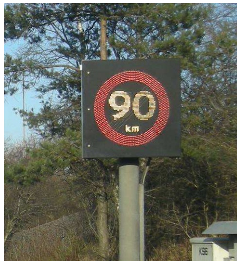
Figur 6.3: Variabel prismetavle (th.) og variabel tavle med lys (tv.).
