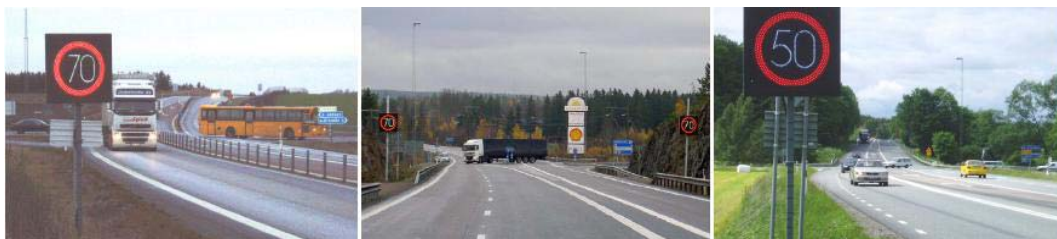
Figur 10. Variable hastighedstavler ved hhv. Lemmeströ, Hudiksvall samt ved Vanneberga. (Lindkvist et al. 2006)
