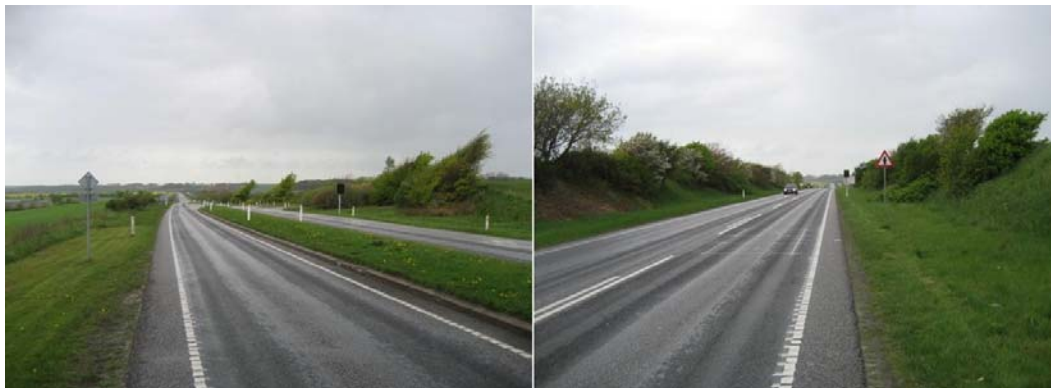
Figur 21. Oversigtsforhold ved Bajlumvej. Billederne er taget mod nord. Tv. ses oversigtsforholdet for de sydgående trafikanter. Th. ses oversigtsforholdet for de nordgående trafikanter, der ankommer til krydset.
