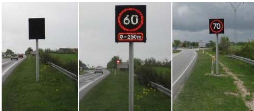
Figur 13. Anvendte variable tavler ved de respektive kryds. (th.) slukket tavle, (midt) Bajlumvej samt Vestmorsvej og Lyngbro (th.).
