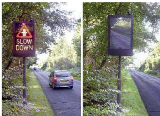
Figur 9. Variabel tavle ved Norfolk - tændt hhv. slukket. (Winnett, Wheeler 2002)
