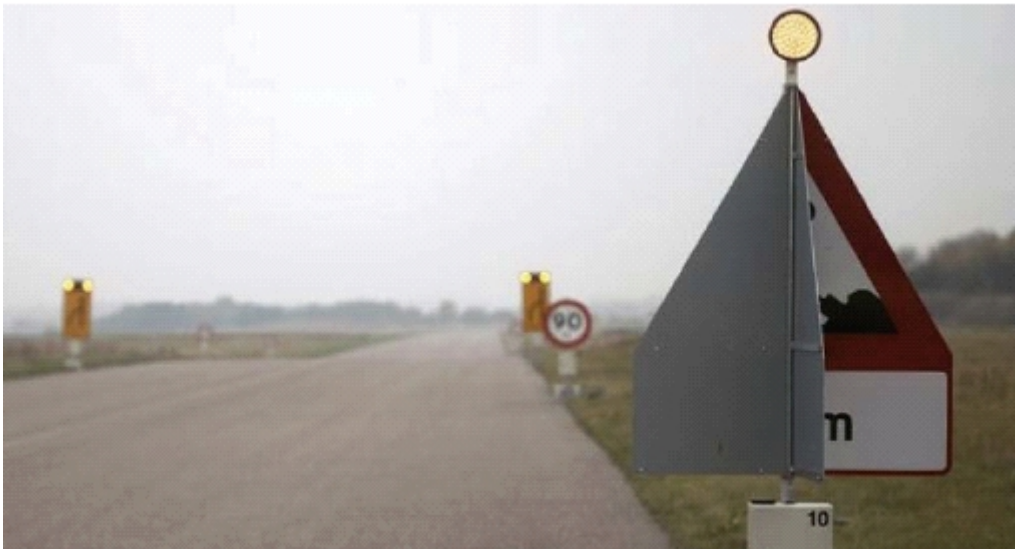
Figur 2. Eksempel på variable tavler ved vejarbejde. (Krenk et al. 2007)
