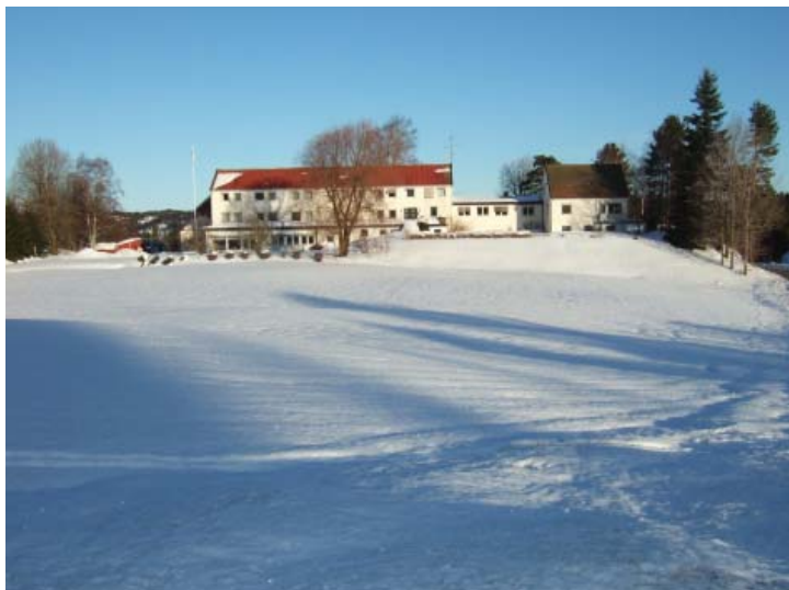
Bilde viser eksisterende bygning / behandlingssenter som skal rives og erstattes av et nytt moderne behandlingssenter
