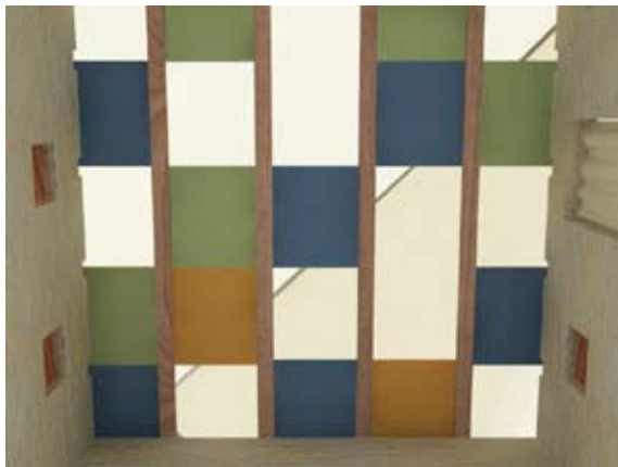
III.200 Loftet danner om dagen åbninger, hvor dagslys kan trænge ind i rummene, hvorved disse oplyses uden brug af kunstig belysning.
