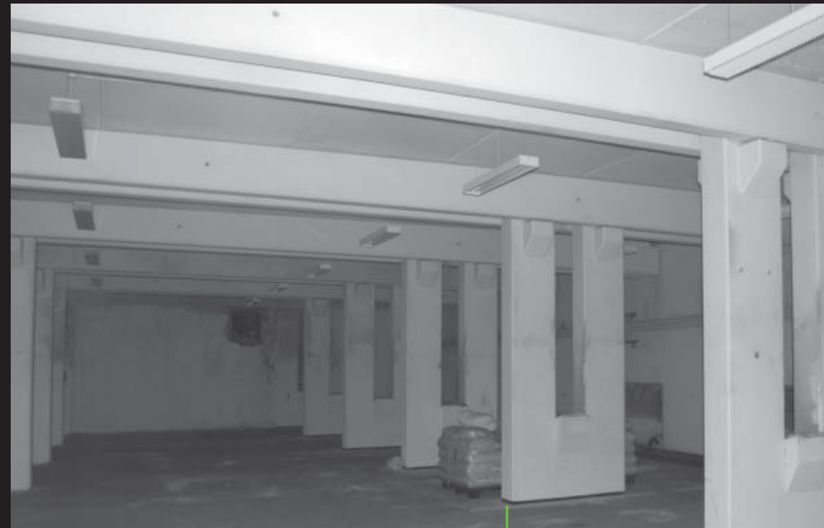
LAGERRUM De markante søjler opdeler og definerer rum i rummet.
