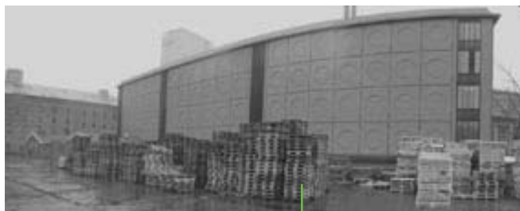
PLADSEN VEST FOR LAGERKÆLDEREN
