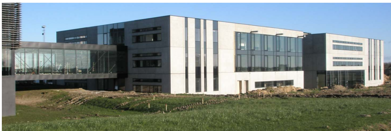
Figur c: Den virkelige bygning under opførelse (billede fra case).
