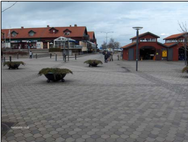
Figur 12.2 Belægningen på Fiskertorget med betonsten i store felter og bånd af brosten.
