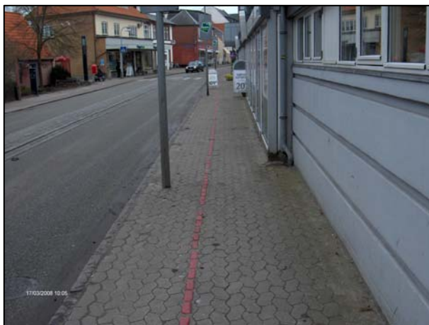
Figur 8.1 Fortovsbelægningen med betonsten.
