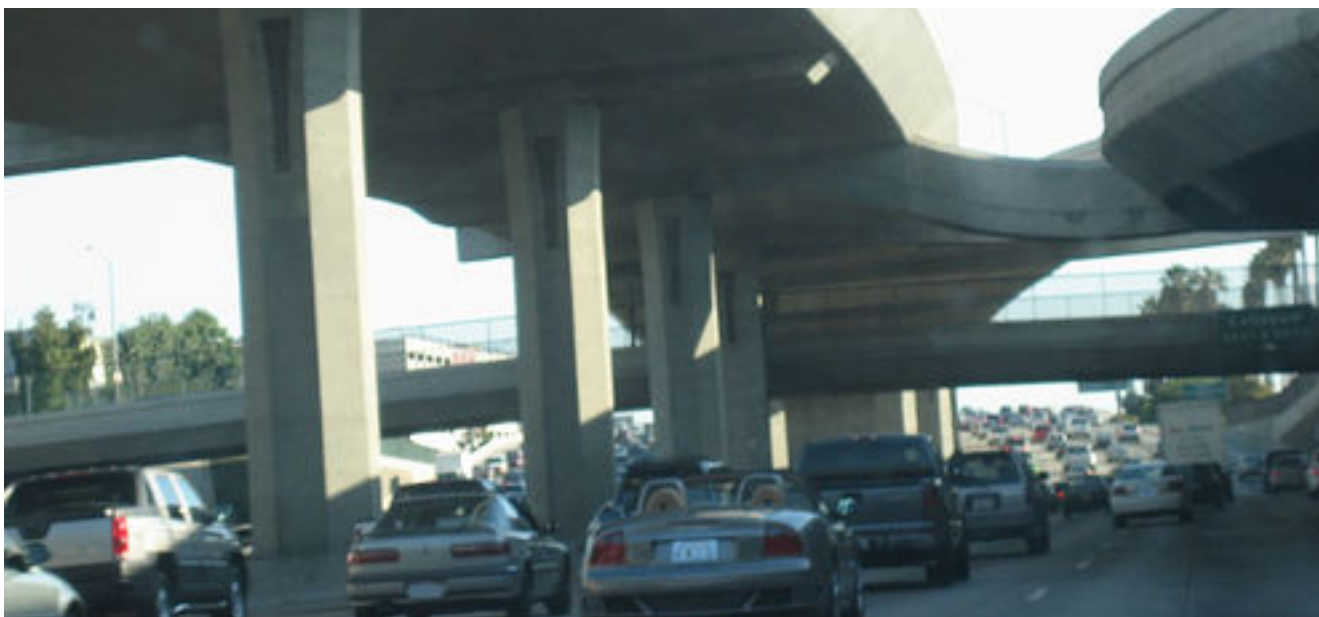
Figur 5.4: Eksempel på hvordan motorveje kan bestå af to dæk (Harbor Freeway, Los Angeles) [Caltrans Photo Gallery].
