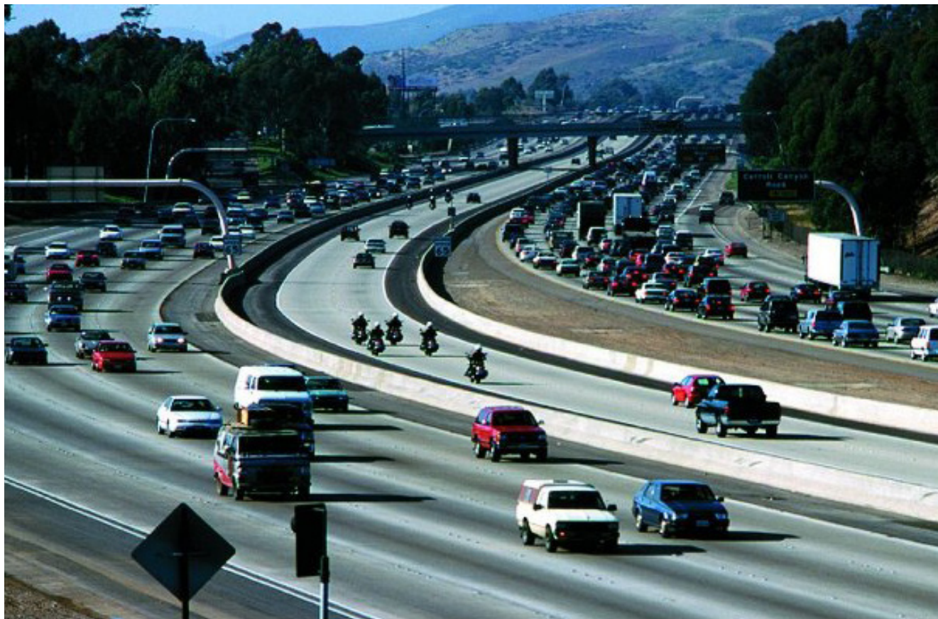
Figur 5.8: Eksempel på separate high-occupancy lanes adskilt fra de almindelige kørespor med betonelementer [ukendt oprindelse].
