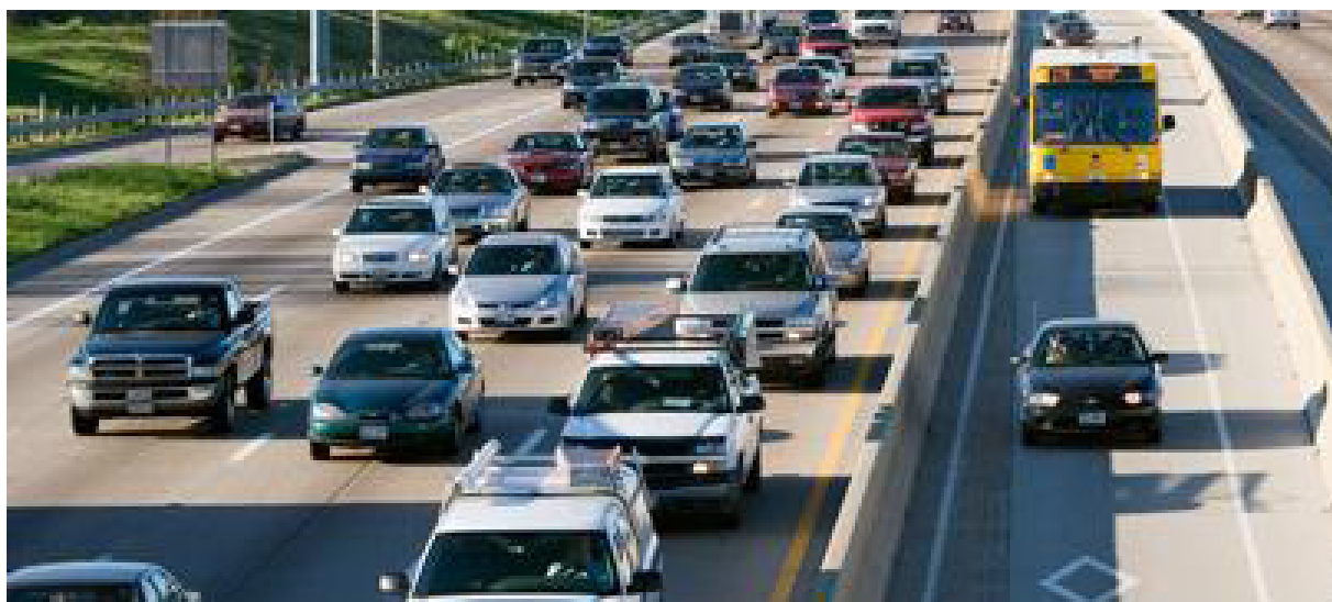
Figur 5.6: Eksempel på en amerikansk motorvej med High-occupancy lane [FHA, 2007].
