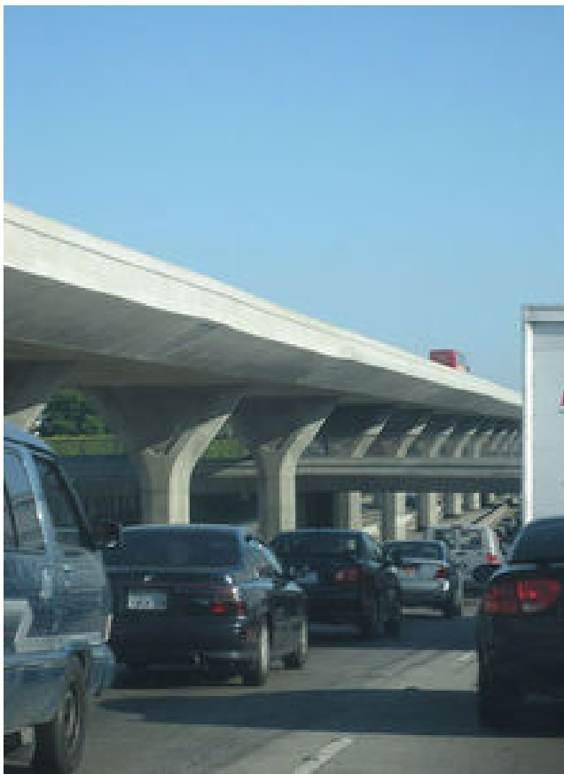
Figur 5.7: Eksempel på separate high-occupancy lanes bygget ovenpå den eksisterende [FHA, 2007].
