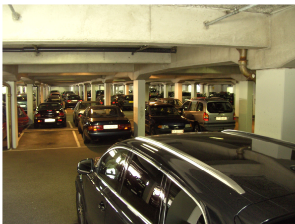
Figur 52. Den nedre del af parkeringsanlægget Preislers Plads.
