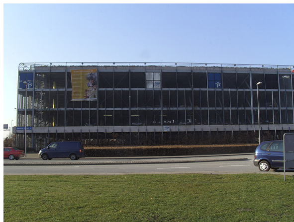
Figur 28. P-huset er lokaliseret i den sydøstlige del af Randers Midtby inden for centerringen. Det vurderes, at parkeringsanlægget er attraktivt for handlende både i weekenden og til hverdag.
