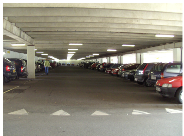
Figur 47. Den nedre del af parkeringsanlægget Fischers Plads.
