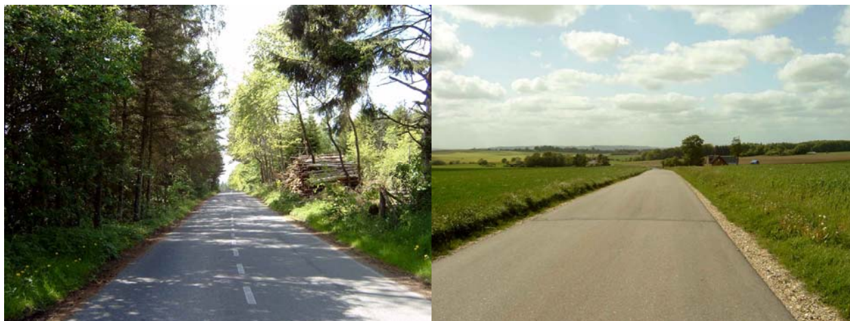
Figur 4.5 Venstre: Vejstrækning med faste genstande tæt på kørebanen. Højre: Vejstrækning uden faste genstande.
