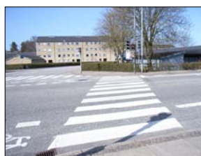
Fodgængerovergang med signal
