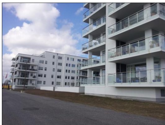
Billede 53 Nybyggeri langs havnefronten
