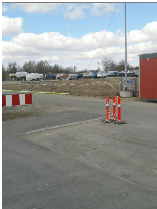
Billede 57 Byggeplads på havnefronten
