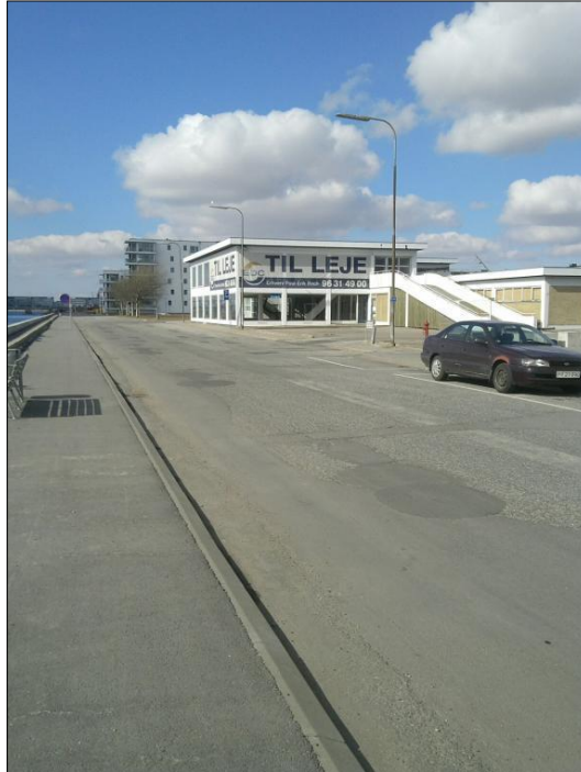
Billede 55 Beton og asfalt på havnefronten
