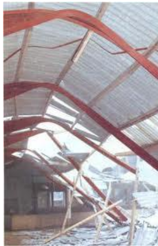
Figur 2: Kipning af stålrammekonstruktion.
