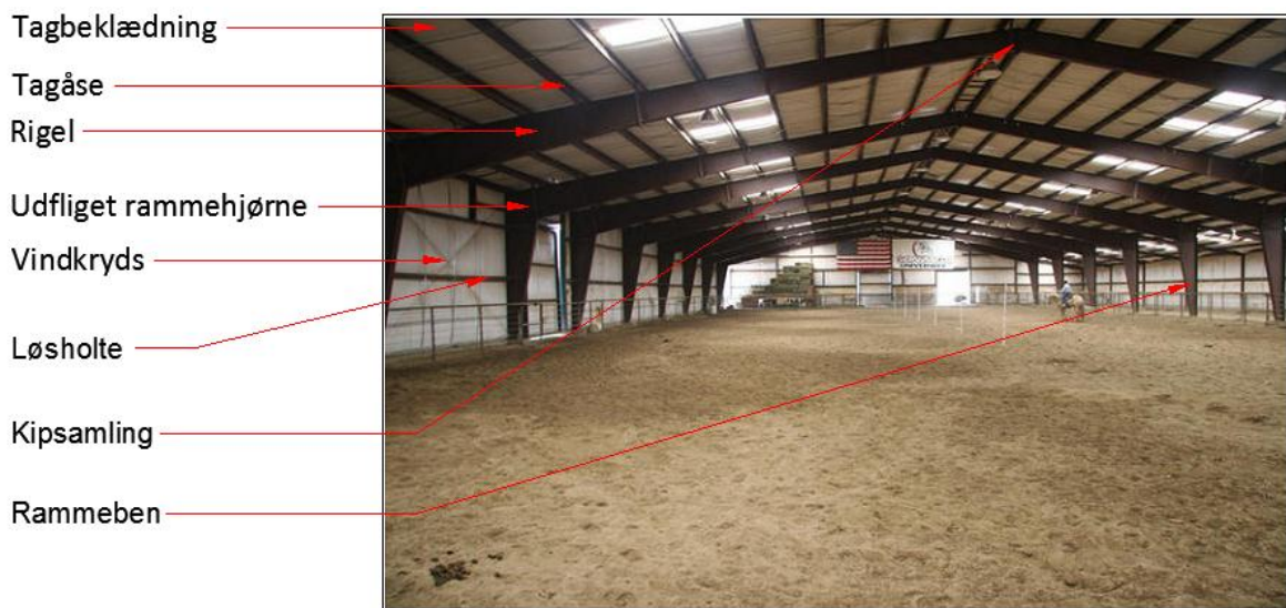
Figur 1: Eksempel på stålhalsskonstruktion. [1]
