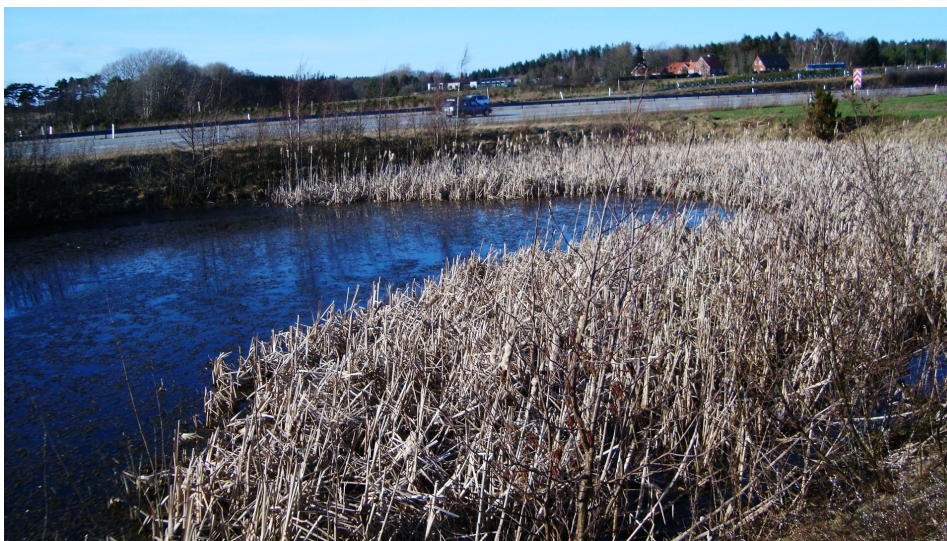
Figur 3.1: Nordlige del af regnvandsbassin 302,9, marts 2012
