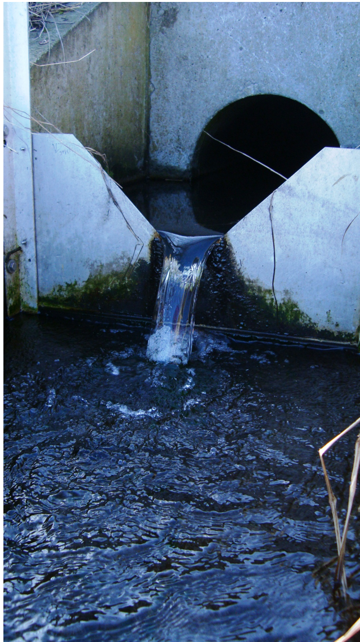
Figur 6.1: Indløb med Thomson overløb den. 22 marts 2012
