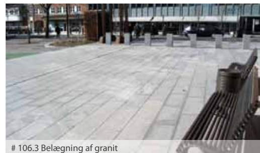
# 106.3 Belægning af granit
