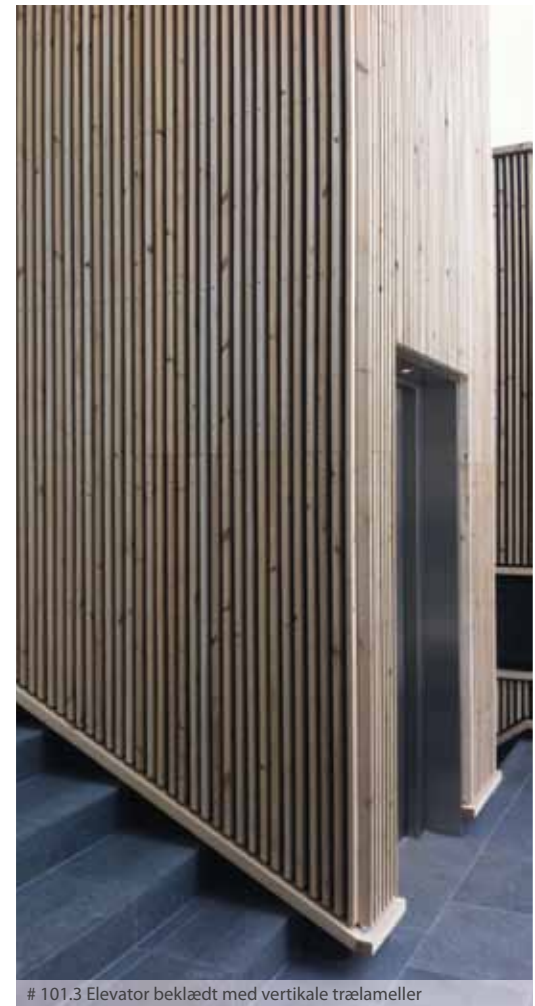
# 101.3 Elevator beklædt med vertikale trælameller
