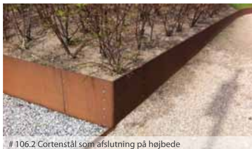
# 106.2 Cortenstål som afslutning på højbede
