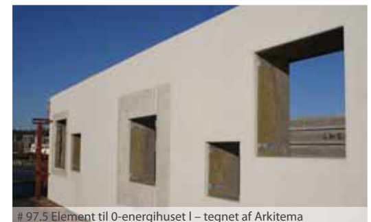
# 97.5 Element til 0-energihuset I – tegnet af Arkitema
