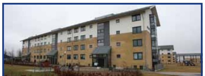
4: Vest for sitet ligger Frederikshavn Boligforenings boligblokke i fire etager. Disse vil normalt have en høj densitet, men der er store udearealer i forbindelse med blokkene, og dermed mindskes tætheden i området.
