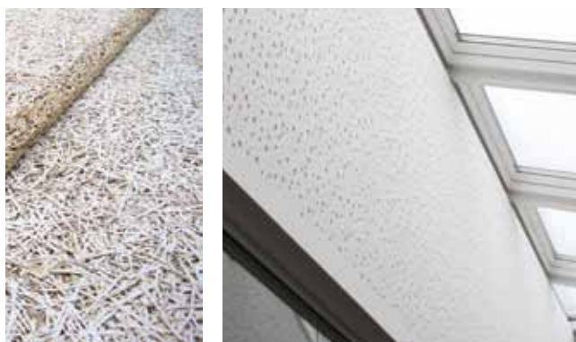
Fig. 3.39 Loftet beklædes med paneler, der forbedrer rummets akustik.
