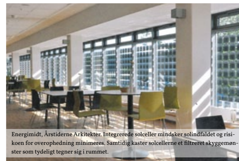
Solceller monteret vertikalt
