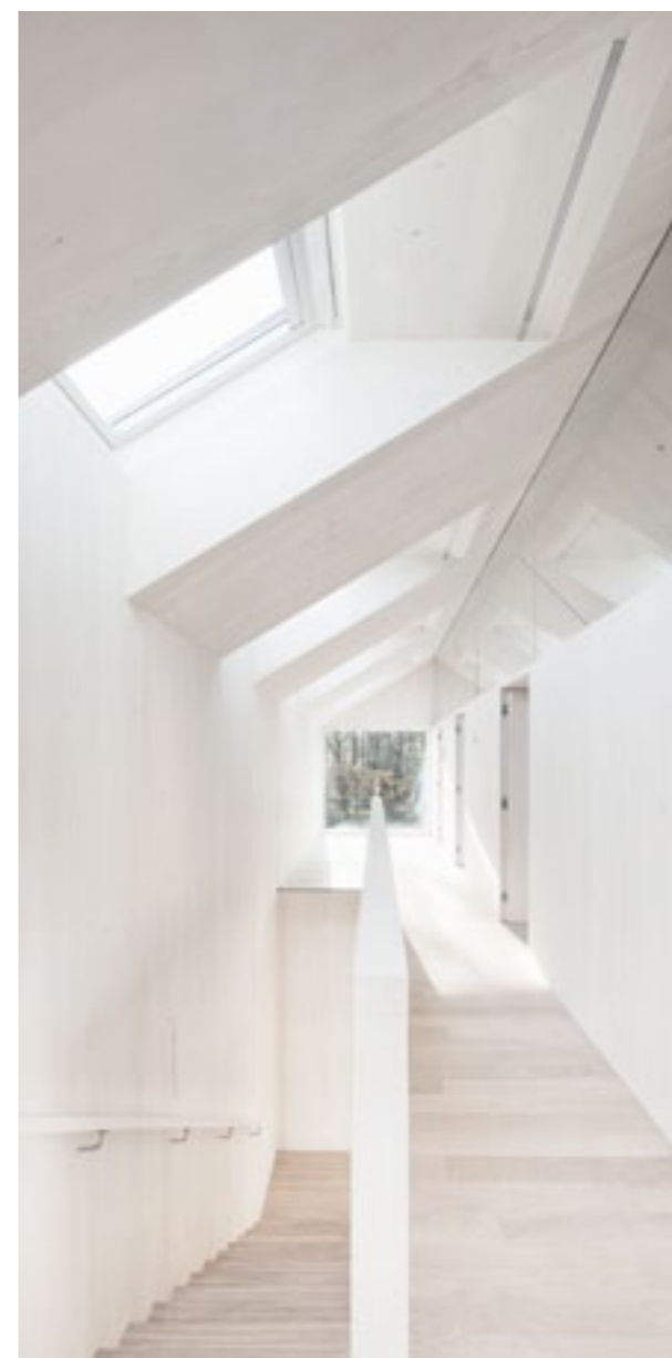
Sunlighthouse, HEIN-TROY Arkitekten. Dagslyset trænger ind i alle rum, gennem glas skillevæggene som er ført til kip.
