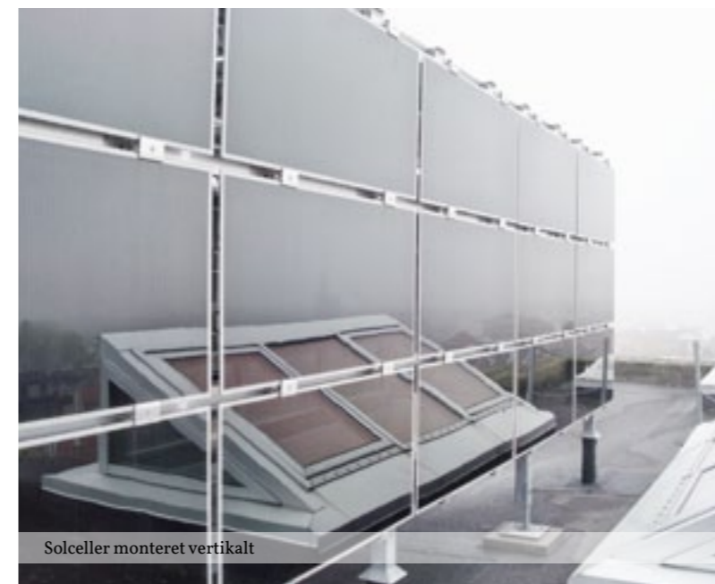
Sunlighthouse, HEIN-TROY Arkitekten. Solcellerne er orienteret optimalt og smatidig hævet for at undgå skygge fra skoven
