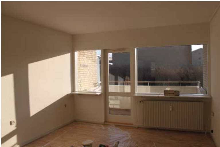
III. 66. Foto mod syd i en af de eksisterende lejligheder.
