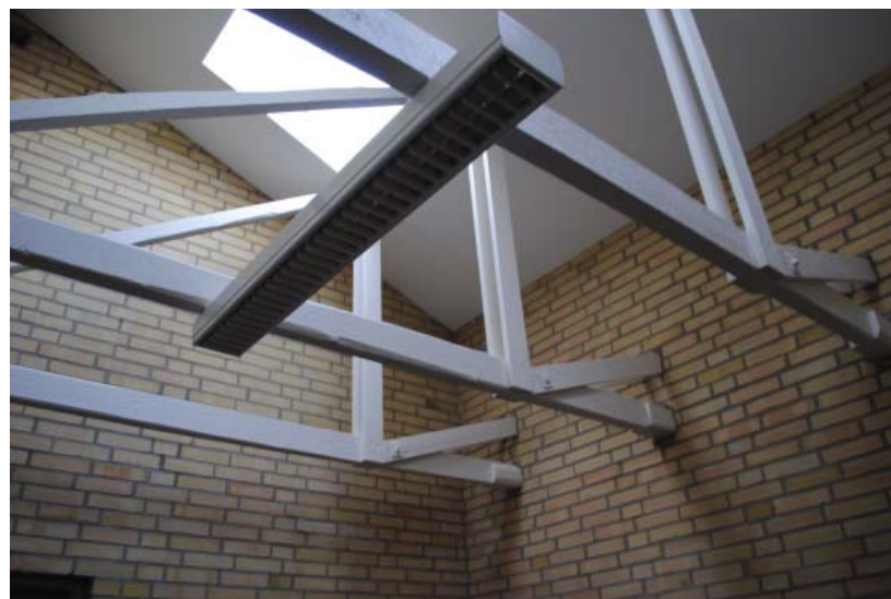
III 26. Tagkonstruktionen er synlig i toppen af trappeopgangen. Et mindre ovenlysvindue sørger for en smule dagslys til trappeområdet.
