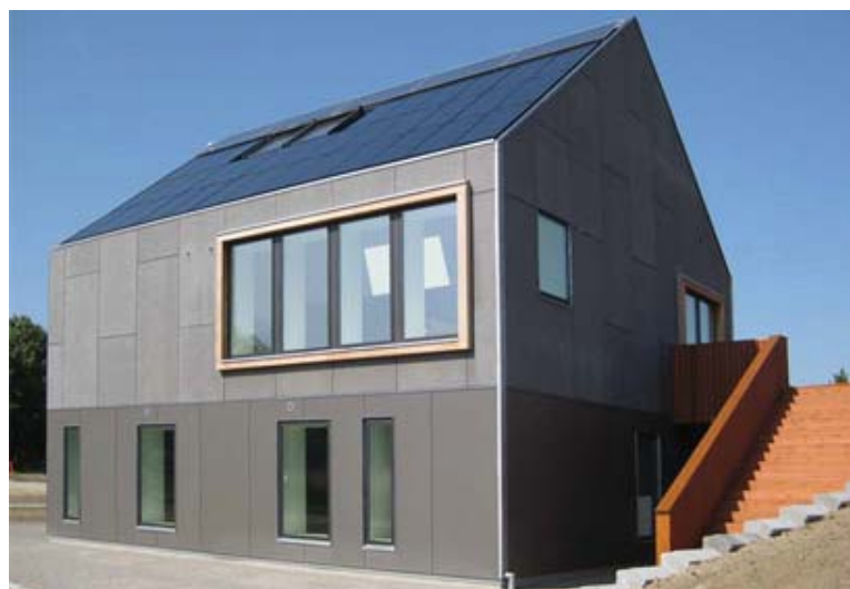
III. 45. Sorte monokrystallinske solcellepaneler integreres i tagfladerne.
