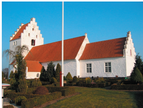
Figur 9.21: Obstruktion i punktet 811. Billedet er taget i punktet.
