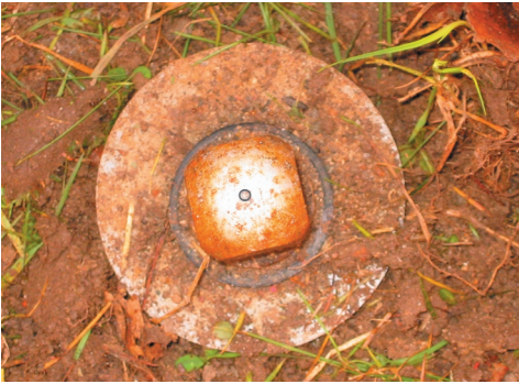
Figur 9.7: Et 10-km punkt i form af en skruepløk placeret ca. 60 cm under terræn. Fordybningen er markeret med en grå ring på billedet.
