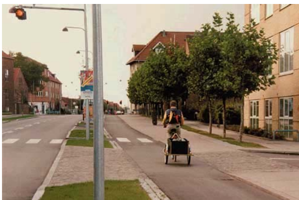
Figur 6.9. Overkørsel som forbinder en privat ejendom med den offentlige vej. [Vejdirektoratet - Vejreglerådet, 2000b (WWW)]
