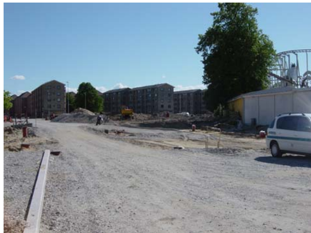
Figur 6.4. Eksempel på vejforlægning i Aalborg. Vejen til venstre flyttes over langs muren til højre.
