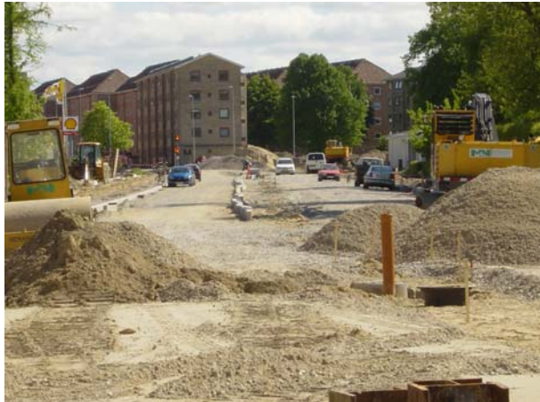
Figur 6.3. Eksempel på vejudvidelse i Aalborg, hvor vejbanen udvides fra to til fire spor.
