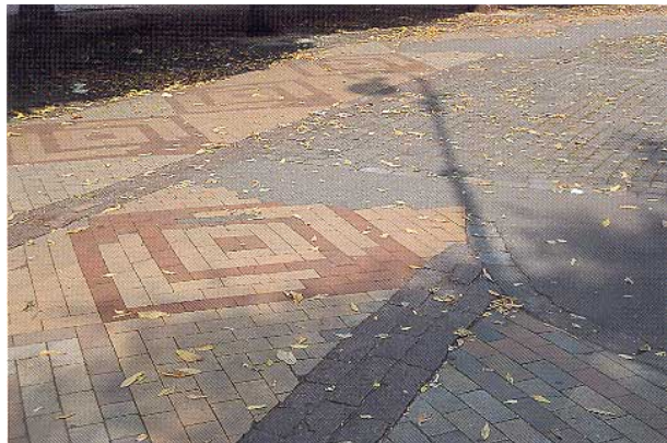
Figur 6.10. Eksempel på belægning. [Vejdirektoratet - Vejregelrådet, 1992 (WWW)]
