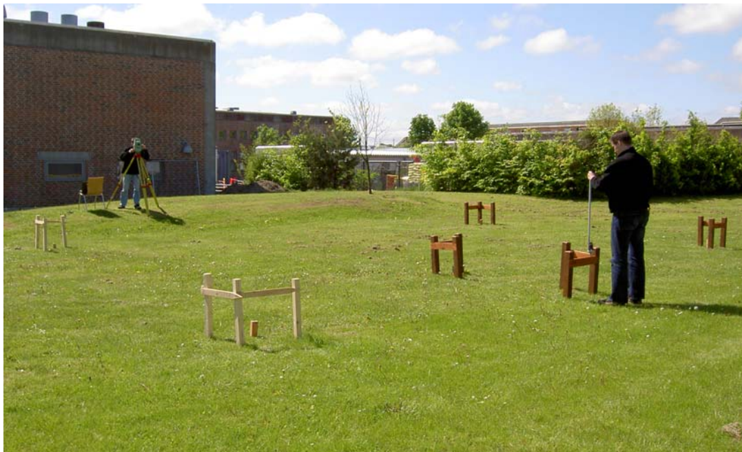
Figur F.11: Opstilling samt afsætning af Fib. 10b på galger.
