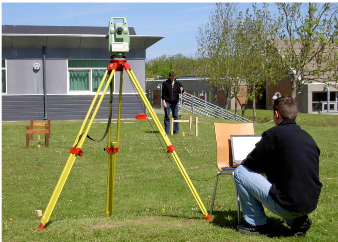
Figur F.12: Opstilling samt afsætning af Fib. 10b på galger.
