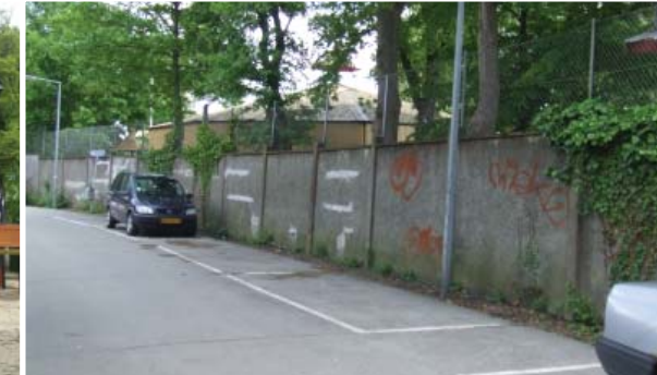
III. 370: Eksisterende mur
