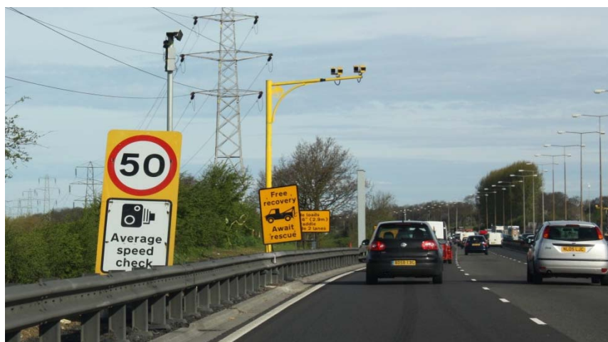
figur 8.4: Skiltning ved stræknings-ATK
