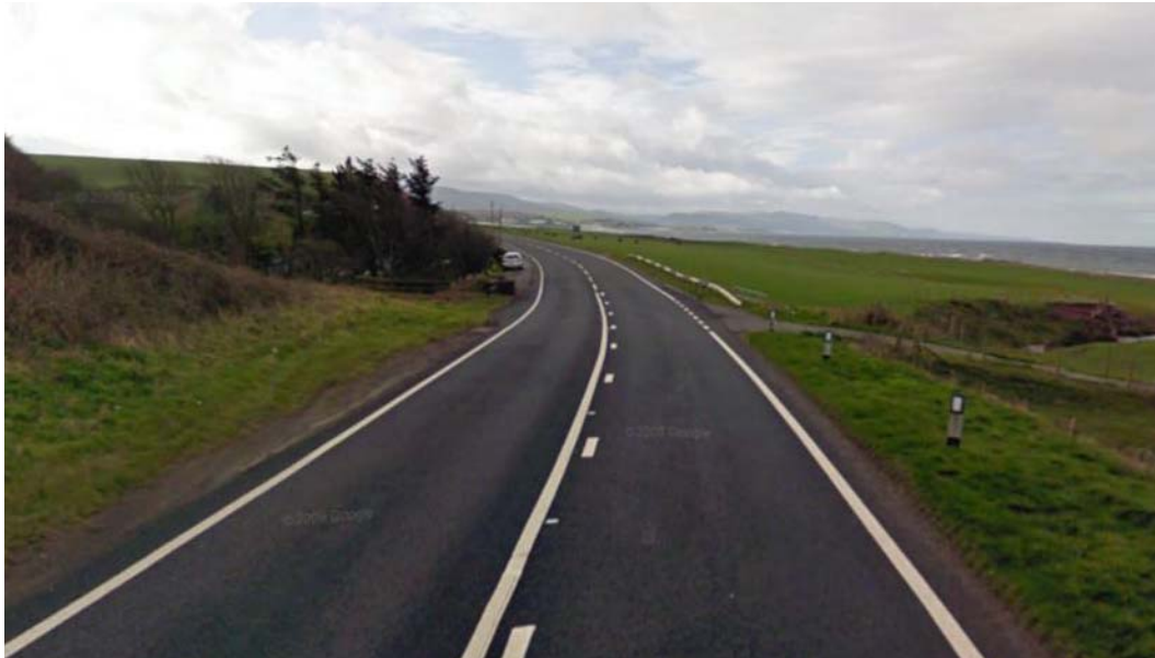
figur A.4: A77 ved Balkenna (Google, 2011)
