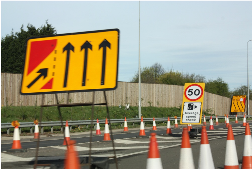
figur 8.5: Indkørsel til strækning med vejarbejde, hvorpå der er opsat stræknings-ATK
