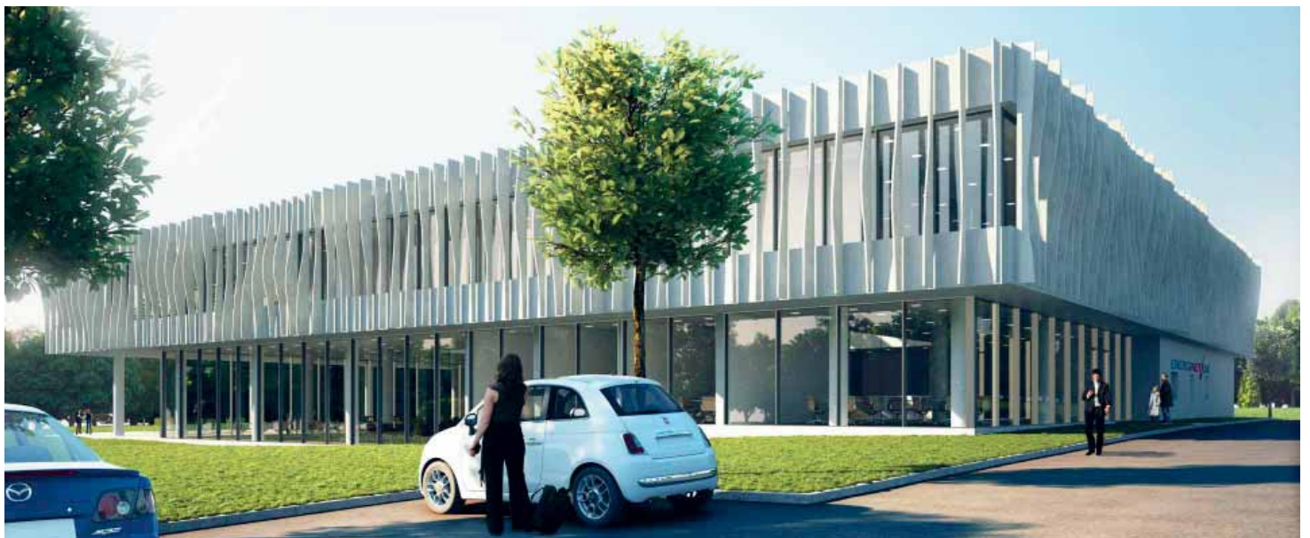
Lavenergikontorhus til Energinet.dk af HLA. Bygningens facader har fast solafskærmning, så gener fra direkte solindfald og overtemperaturer i de udsatte rum undgås.
