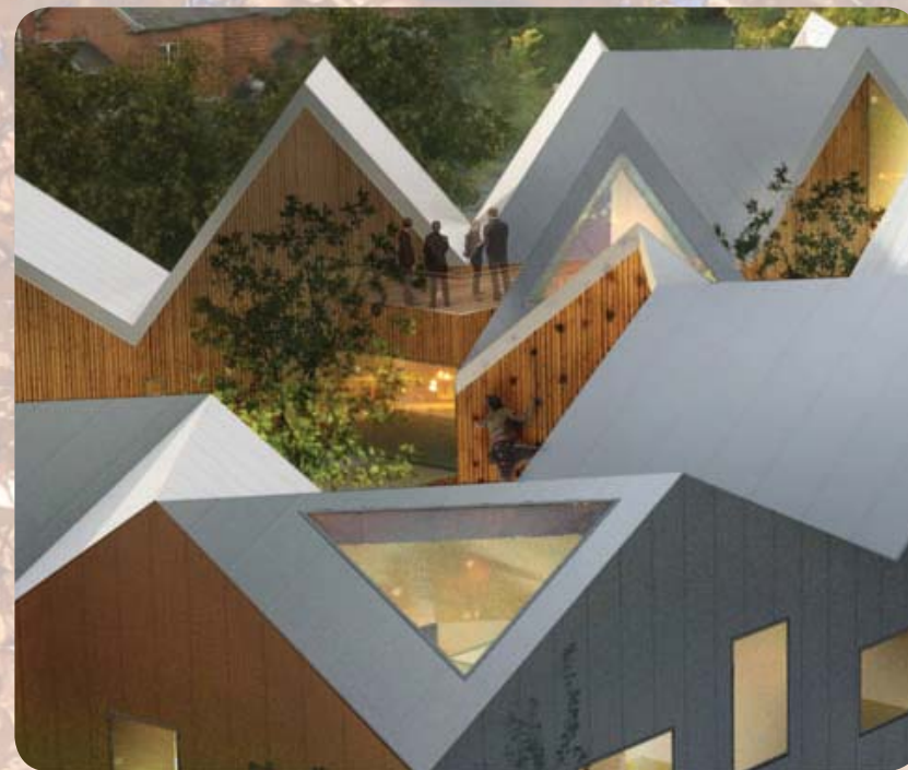
III. 104: Der er direkte forbindelse til uderum fra mange af bygningens rum, deriblandt et stort gårdrum og mindre terrasser.
