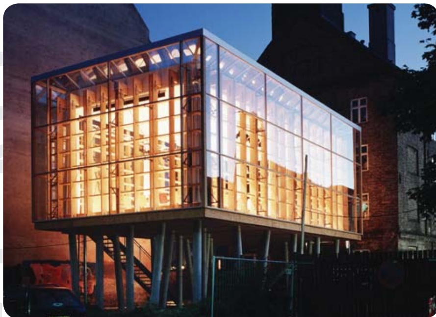
III. 278: Kvarterhuset af Dorte Mandrup Arkitekter. Glasset bæres af en træstruktur på indersiden af glasset. På den måde holdes glasfacaden helt ren.
