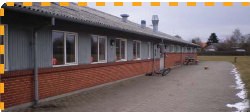
III. 27: Adgangen til hallen forvirrer. Der er ingen indgang i hallens gavl og på langsiden er der intet der indikerer hovedindgang.
