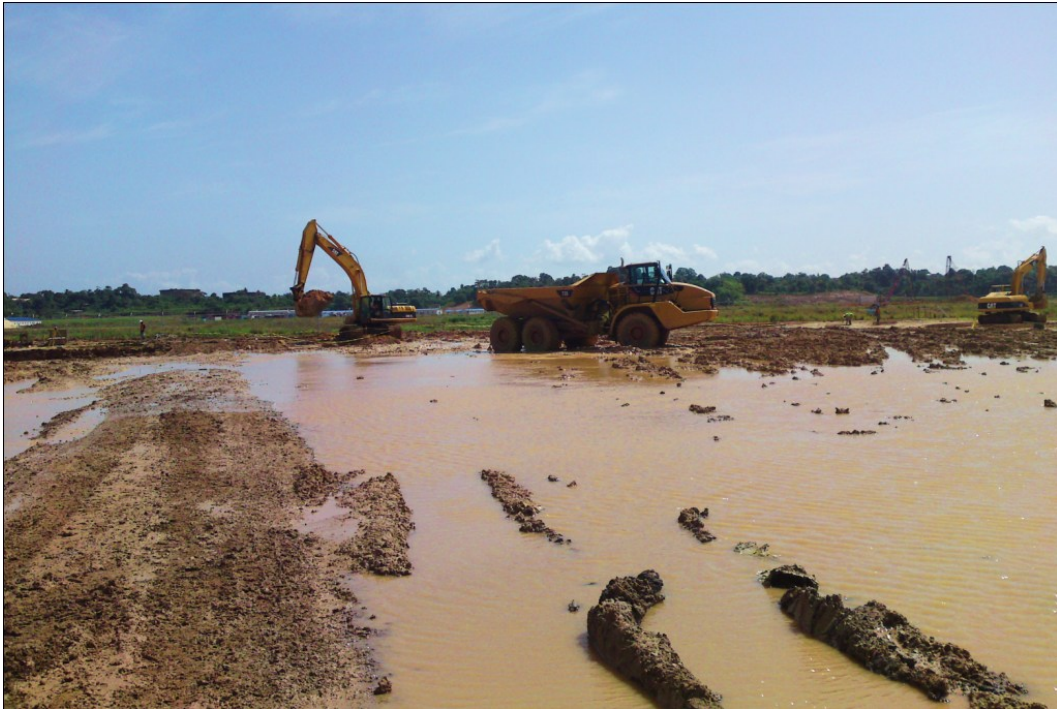
Figur 3.2 Vand på byggepladsen under regntiden.
