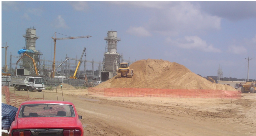
Figur 3.1 Det leverede sand til indbygning bl.a. omkring fundamenter.
