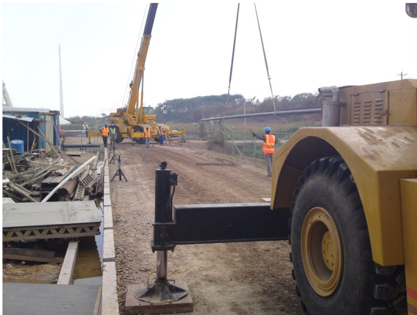
Figur 3.4 En vej på byggepladsen blokeret af to kraner.
