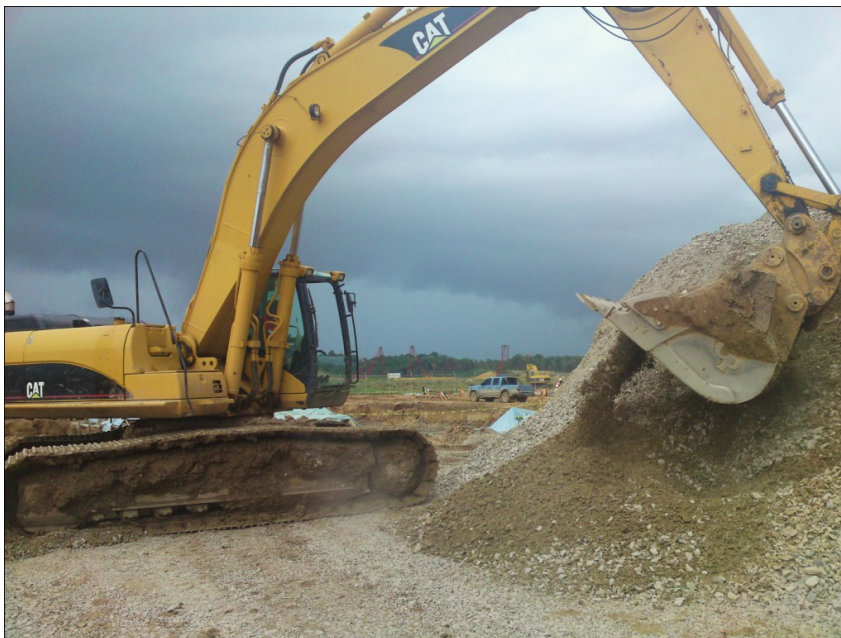
Figur 3.5 Det stabilgruslignende materiale, som blev brugt til opfyldning, for så at blive kasseret og erstattet med rent stenfyld.
