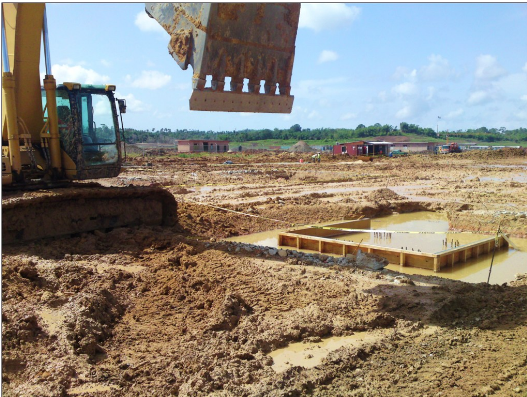
Figur 3.3 Vand i byggegrube, som skal pumpes væk.
