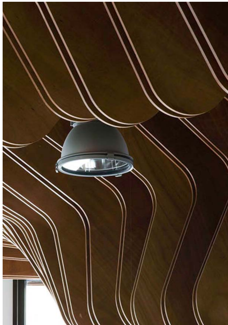
#54 Daglys integreret i tagkonstruktionen med ovenlys vinduer der tilføjer rummet et godt daglys. Green Light House, København, Danmark. Arkitekt, Christensen & Co Architects.
