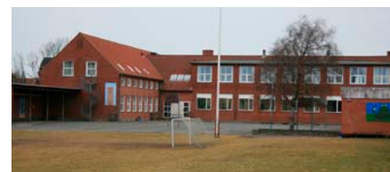
#12 Balling Skole, beliggende ved siden af Balling Hallen.
