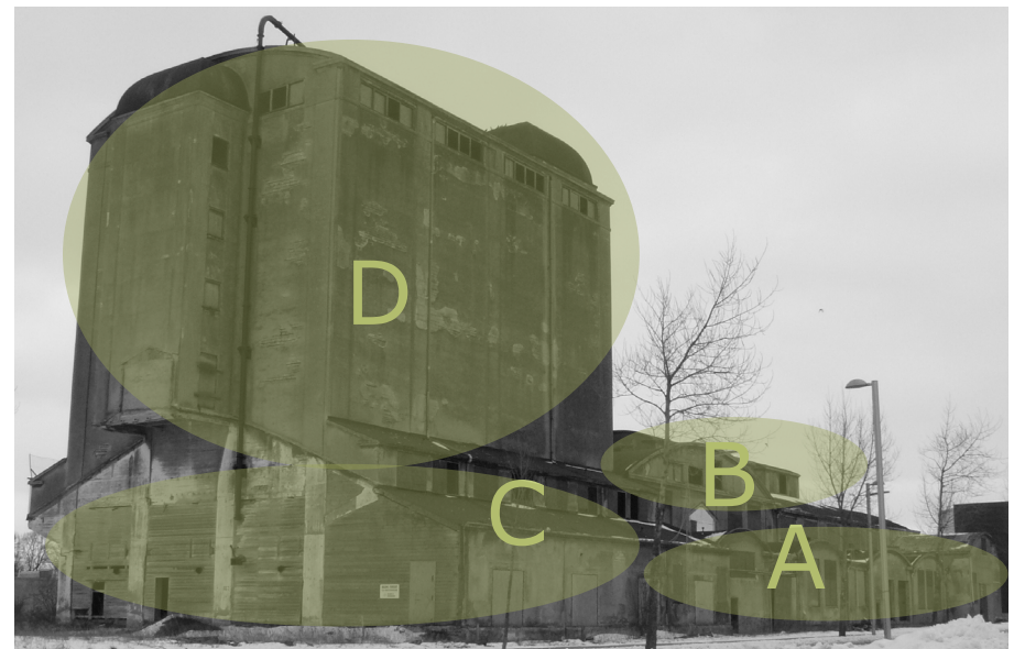
Ill. Bygningens volumenopdeling til etff. afsnit Vol. A - Forhuse Vol. B - Hallen Vol. C - Rum under siloen Vol. D - Siloen
