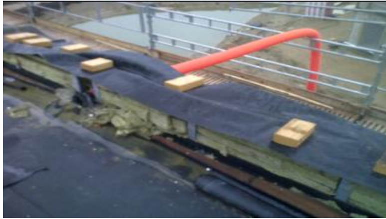
Figur 16 PVC røret fastgjort til brønden har revet sig løs og vand løber ned i isoleringen.
