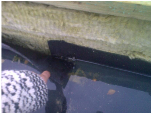
Figur 17 En svejsning er ikke udført godt og vand løber ned i isoleringen
