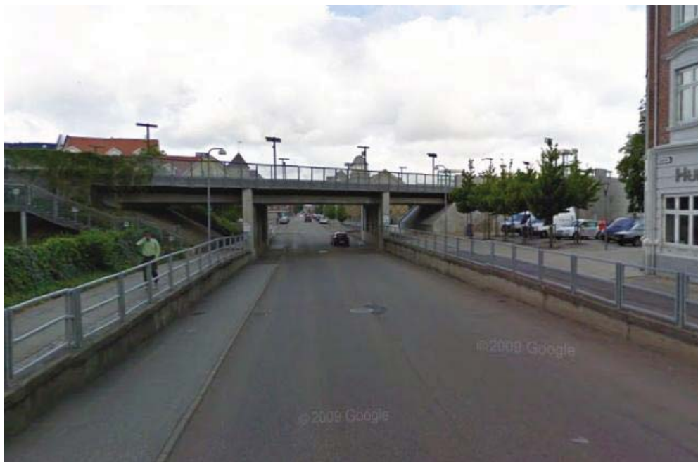
Figur 32 Niveaufri skæring mellem Kastetvej i Aalborg og jernbanen (Google 2009)
