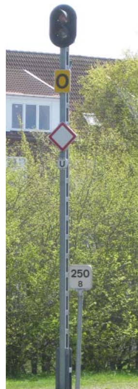
Figur 29 U-signal placeret umiddelbart nord for overkørslen ved Thistedvej
