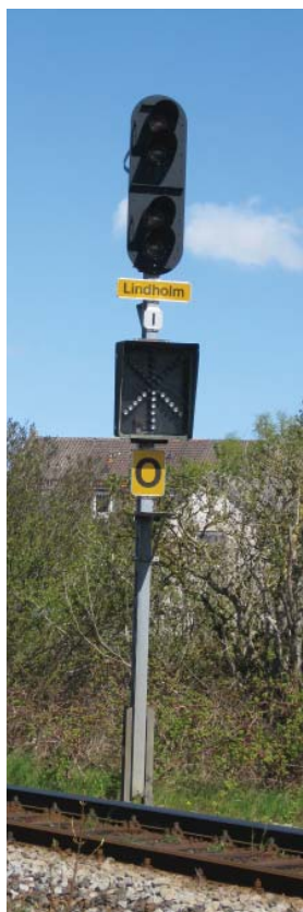
Figur 26 Hoved-signal placeret ca. 90 meter syd for overkørslen ved Thistedvej
