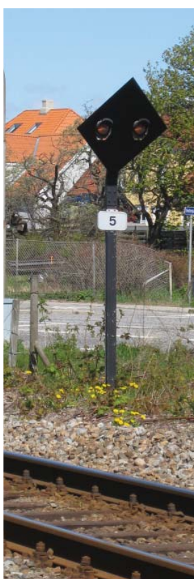
Figur 27 Uordens-signal placeret umiddelbart syd for overkørslen ved Thistedvej
