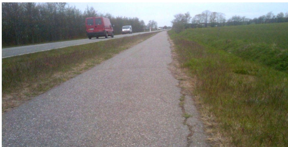
Figur 5.4: Der vil være en naturlig unøjagtighed for opmålingen, da ikke alle tværprofilelementers afgrænsning er lige godt defineret i marken. Her se højrecykelstis højrekant mod yderrabaten.
