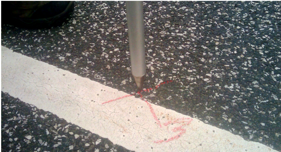
Figur 5.3: Vejens Systemlinie opmåles, det markeres hvor punktet er opmålt første gang. Vejmidten er fundet ved hjælp af stålmålebånd.
