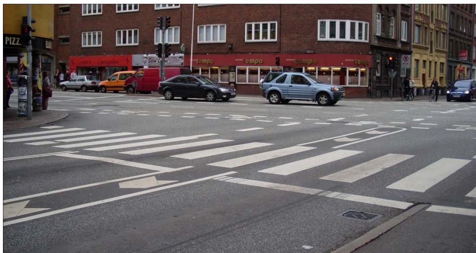
Figur 74 Den østligste overgang på Borgergade i krydset mellem Vesterbro og Borgergade (eget foto)
