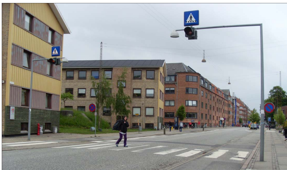
Figur 80 Skiltning og opmærkning af fodgængerfeltet ved krydset mellem Kastetvej og Otte Ruds Gade (eget foto)
