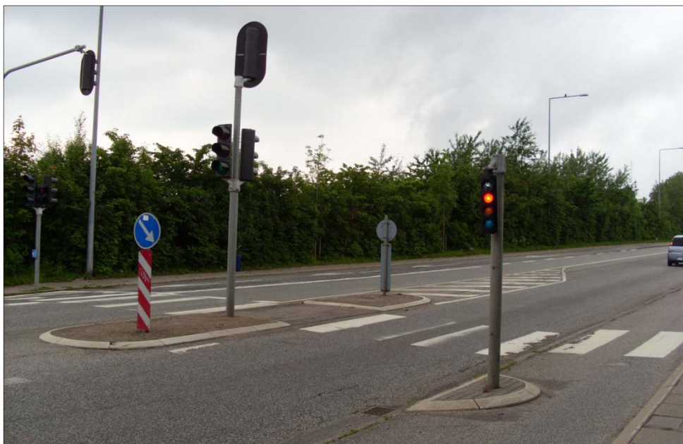
Figur 91 Overgangen ved krydset med Stjernevej, hvor anbefalingen om midterhelle er opfyldt (eget foto)
