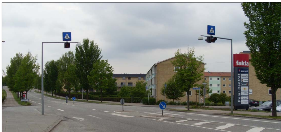
Figur 83 Opmærkning og skiltning af overgangen i krydset ved Umanakvej på Sohngårdsholmsvej (eget foto)
