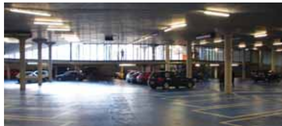
119.3 Parkering under plads i Breda. Her løfter terrænet sig udvendigt, hvilket giver dagslys ind til parkeringen
