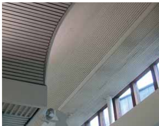
108.3 Kunsten, Aalborg, Alvar Aalto I de store udstillingsrum er loftet beklædt med hvidmalede træpaneler, hvoriblandt der er et lydabsorberende materiale.
