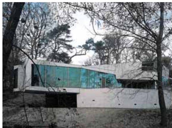
107.2 Möbius House, Naarden, Ben van Berkel Kun enkelte steder i facaden er der huller til vinduer. Bag resten af glasfladen er der beton.
