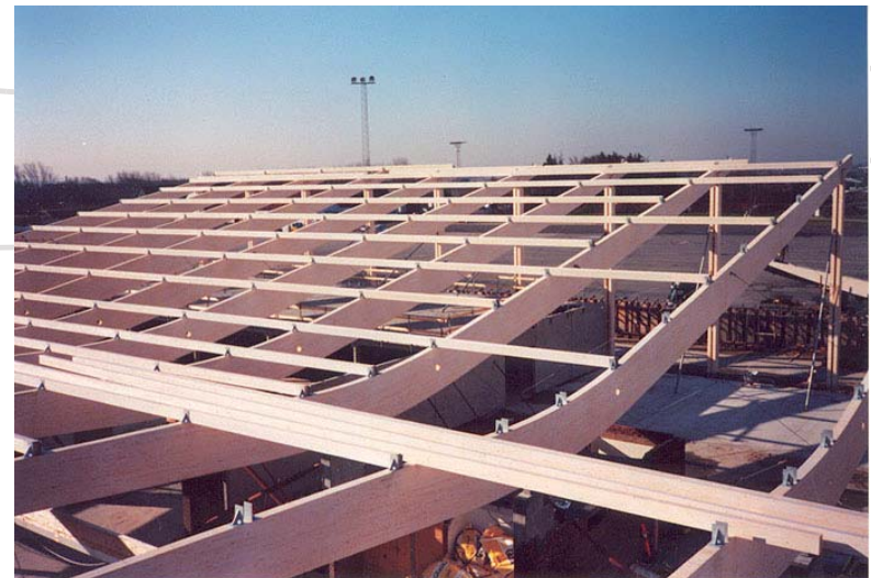
III. 214: Eksempel på tagkonstruktion med svungne limtræsspær
